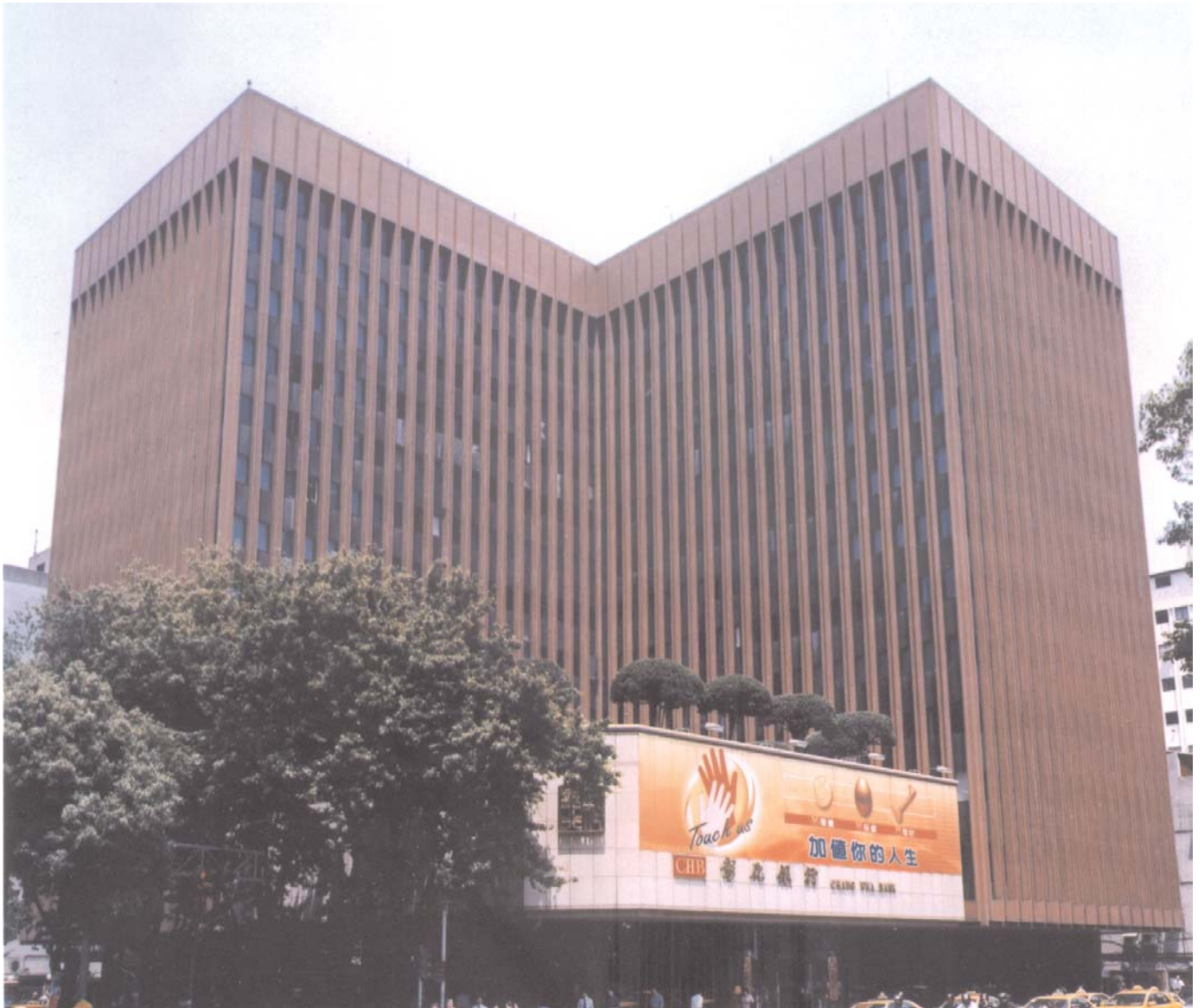
台北總行大樓 CHB Taipei Main Office
