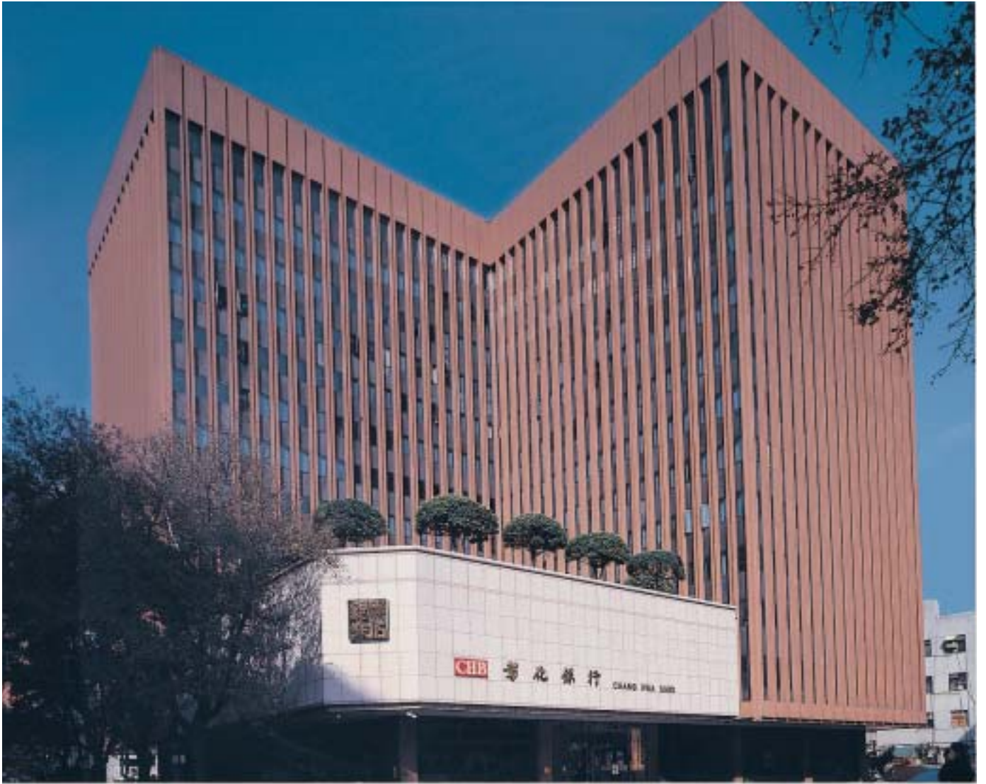
台北總行大樓 CHB Taipei Main Office
