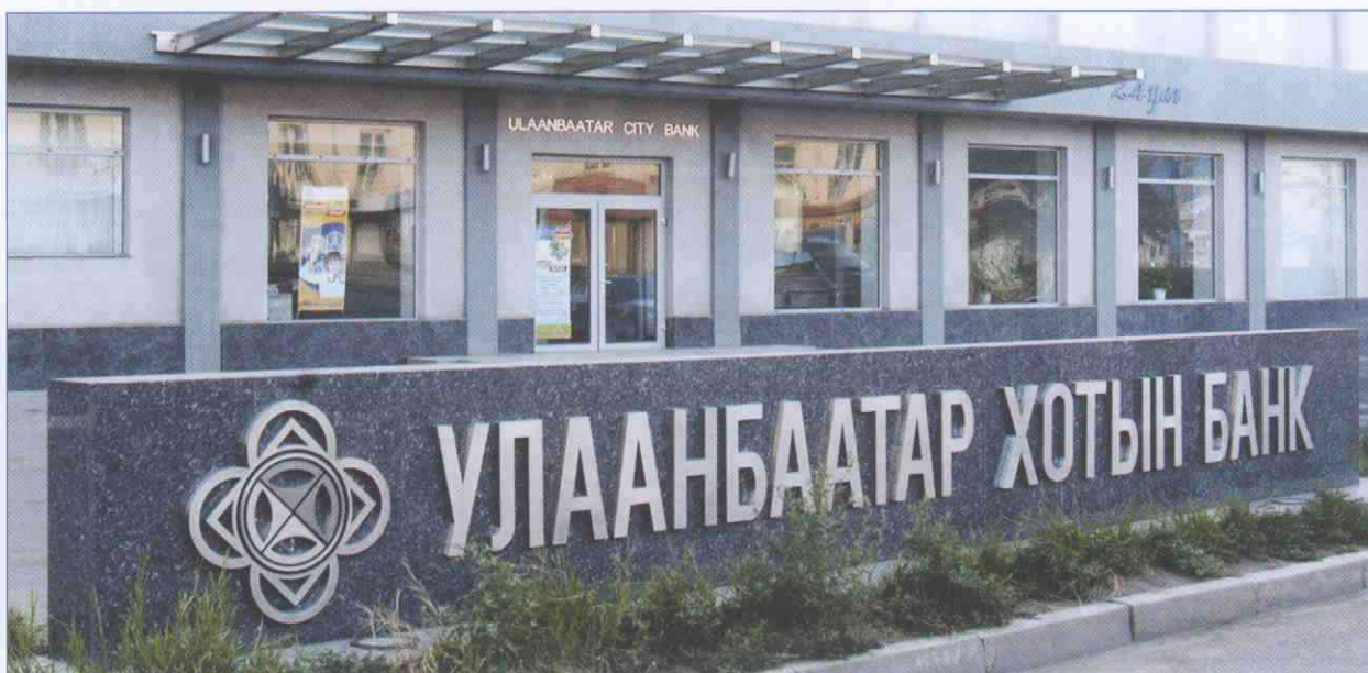
Улаанбаатар Хотын Банкны II тооцооны төв / Ulaanbaatar City Bank Branch No.2
